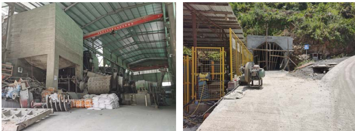
图 1：现场勘查照片
