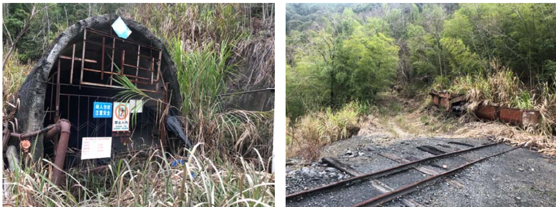
图 1：现场勘查照片
